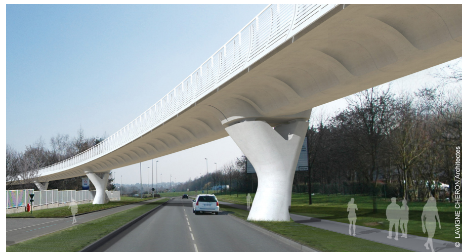
Métro de Rennes – corniches de rive en forme d'écrans en BFUP (Lavigne & Cheron Architectes)
