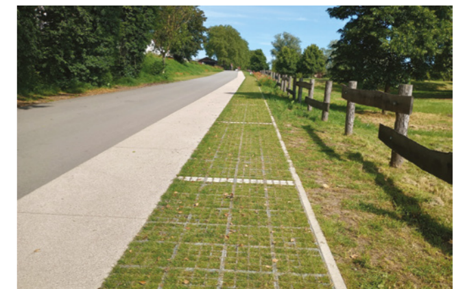
Exemples d'aménagements pour la gestion des eaux pluviales, ©Egis
