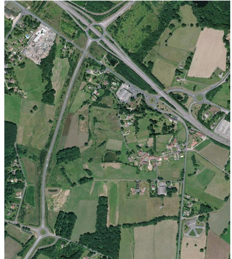
Échangeurs entre la RD 941 et, à l'est, la RD 20 et, à l'ouest, la RD 2000, mise en service en 2007
