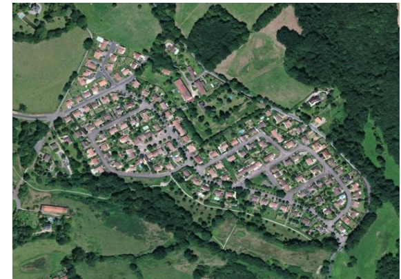
Lotissement isolé à Limoges
